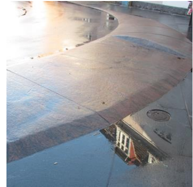
7100_08: Granit blokke i Tønnesgade.
