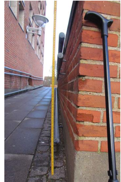
7100_12: Arm- og fodværn i korrekt højde.
