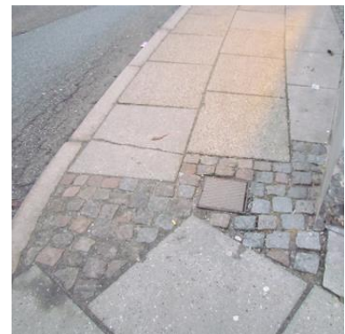
Billede 8900_31: Overgang imellem beton og naturbelægning omkring hjørne.
