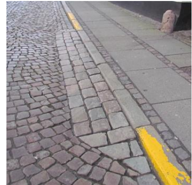
8000_11: Meget veludført kantstensrampe. 4,5 cm. niveauforskel udlignet over 35- 40 cm.
