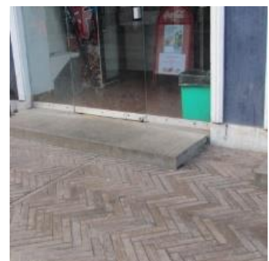
8900_45: Nyt trin ved indgang til butikker mv. i Storegade
