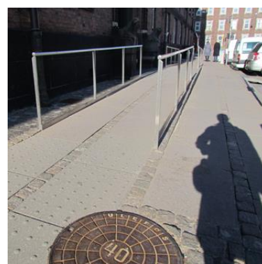
5100_20: Veludført rampe. Falder 1:20.
